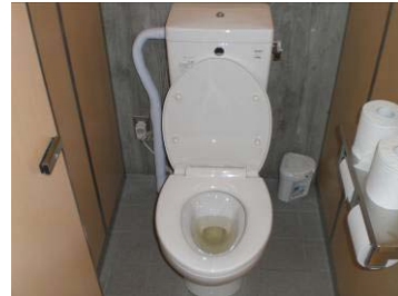
トイレ内部(個室)
