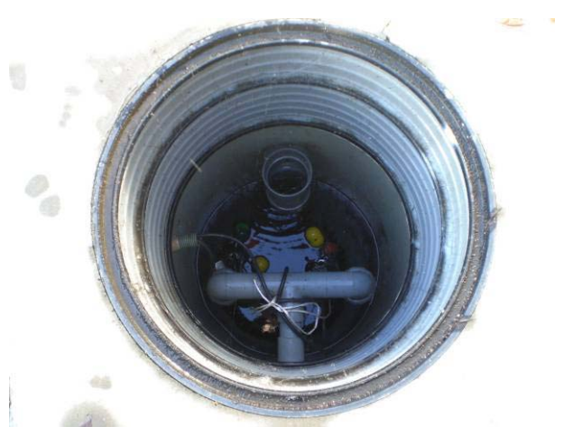
ポンプ槽 A
