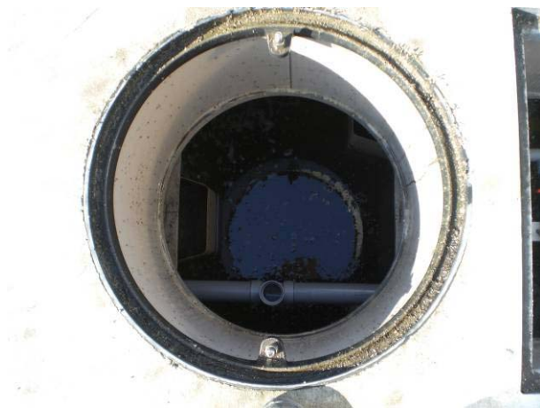
沈殿分離槽(沈殿分離槽第2室)
