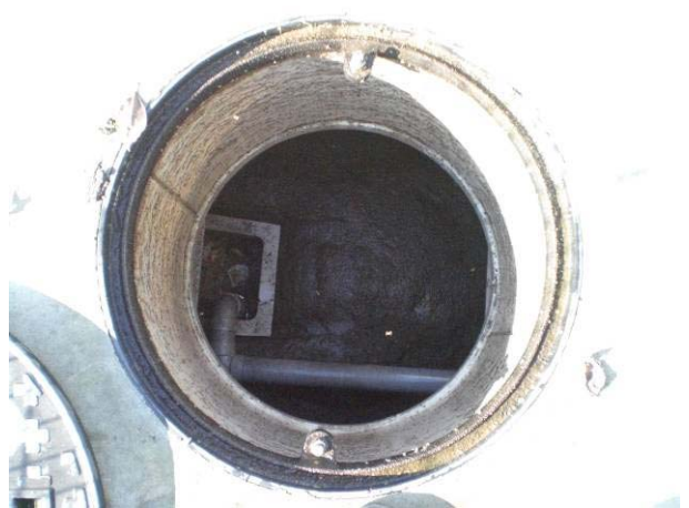
沈殿分離槽(沈殿分離槽第1室)
