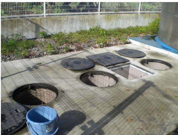
沈殿分離槽(全景)
