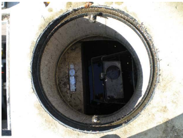
沈殿分離槽(沈殿)
