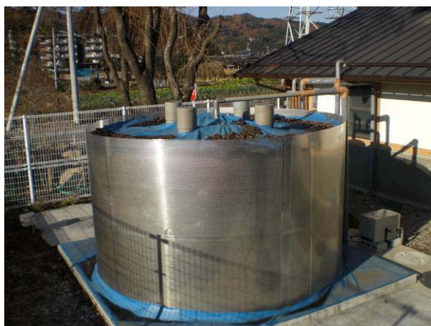
ホーラ槽(全景)
