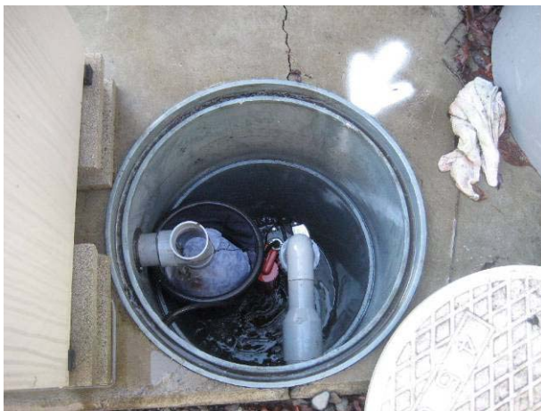
ポンプ槽 B
