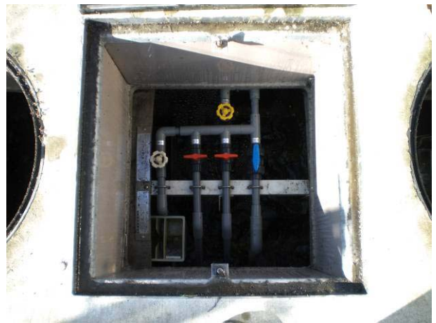
沈殿分離槽(接触ばっ気槽)
