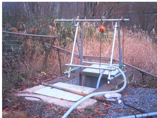
流入水の取水場
