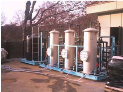
図 装置設置状況
