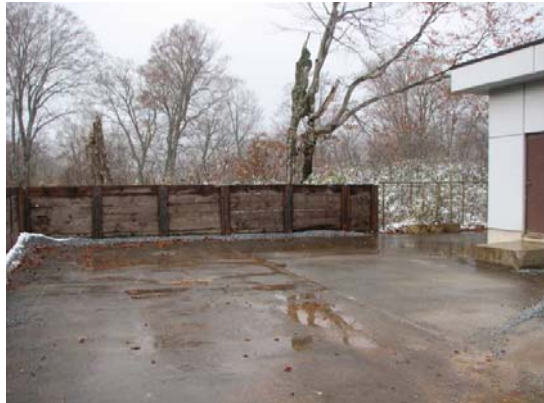
新玉川温泉 試験設置場所撤去確認
