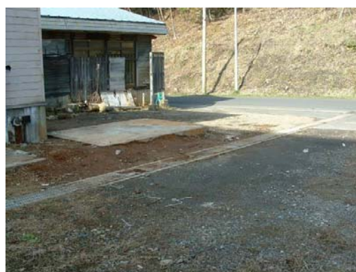
装置撤去後の現場
