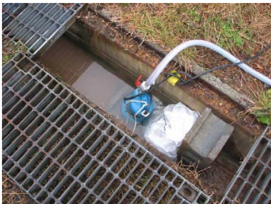
側溝からの温泉排水採取
