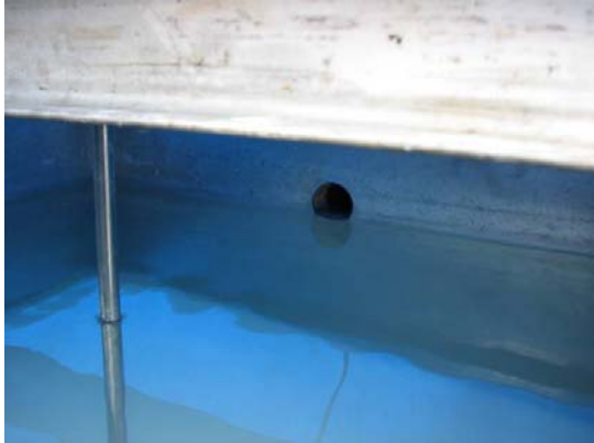
凝集沈殿槽での上澄水越流状況
