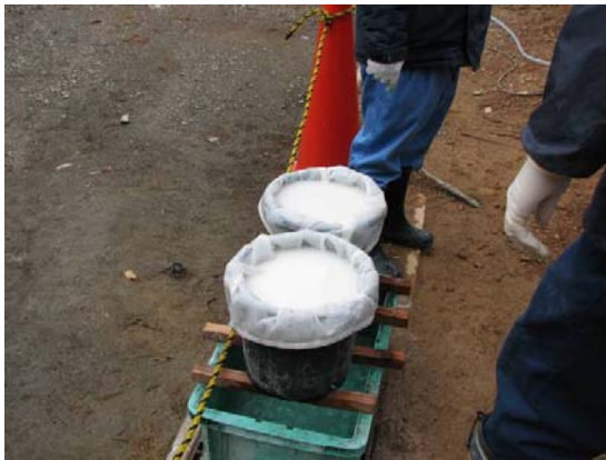
ろ過袋による重力脱水
