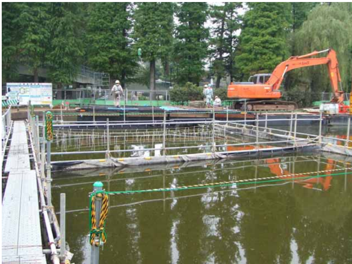
写真5 別所沼における隔離水界側からみた護岸改修工事 (平成 18 年 10 月 20 日)
