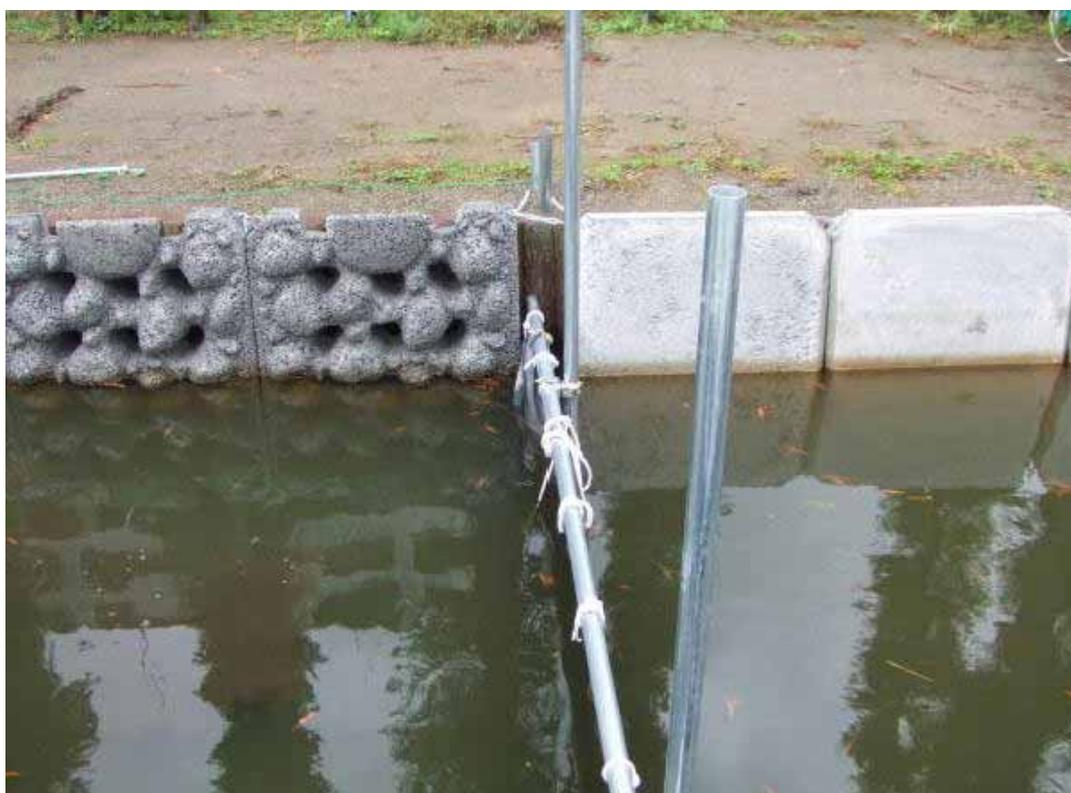
写真4 浄化ブロック設置状況
