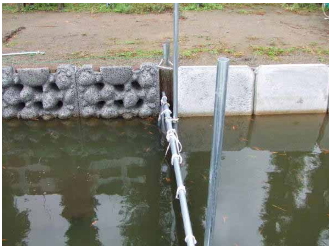
写真4 浄化ブロック設置状況 (左：処理区の浄化ブロック、右：対照区のコンクリートブロック)
