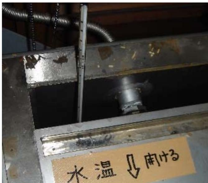
図 5-6 貯水槽内の温度計設置状況
