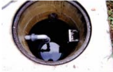
余浄水貯留槽
