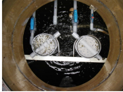
貯留槽(活性炭吸着筒)
