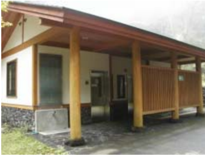
写真1 公衆トイレの外観
