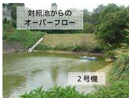
実証対象機器の設置状況
