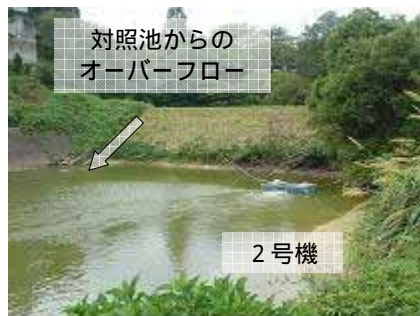
実証対象機器の設置状況
