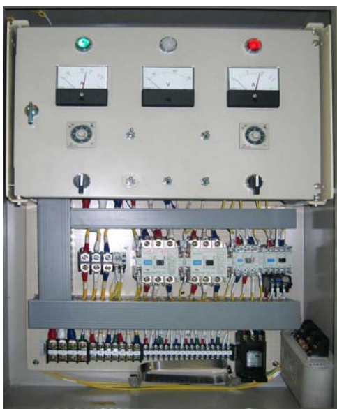
【制御盤・操作パネル開閉前】
