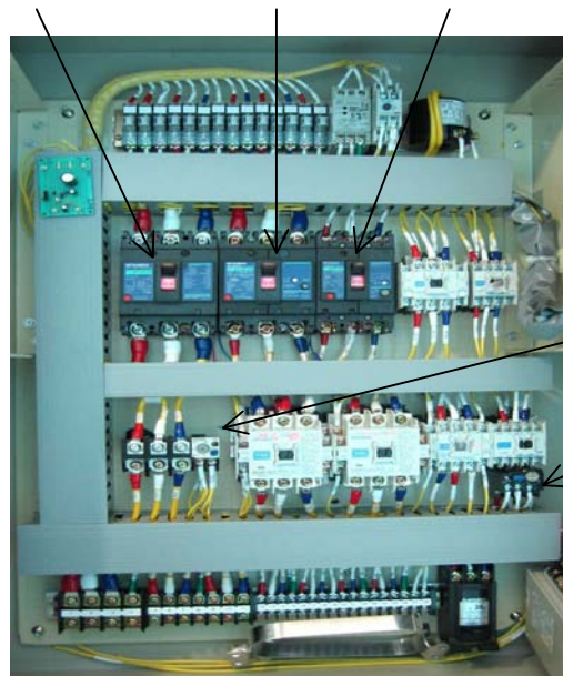
【制御盤・操作パネル開閉後】
