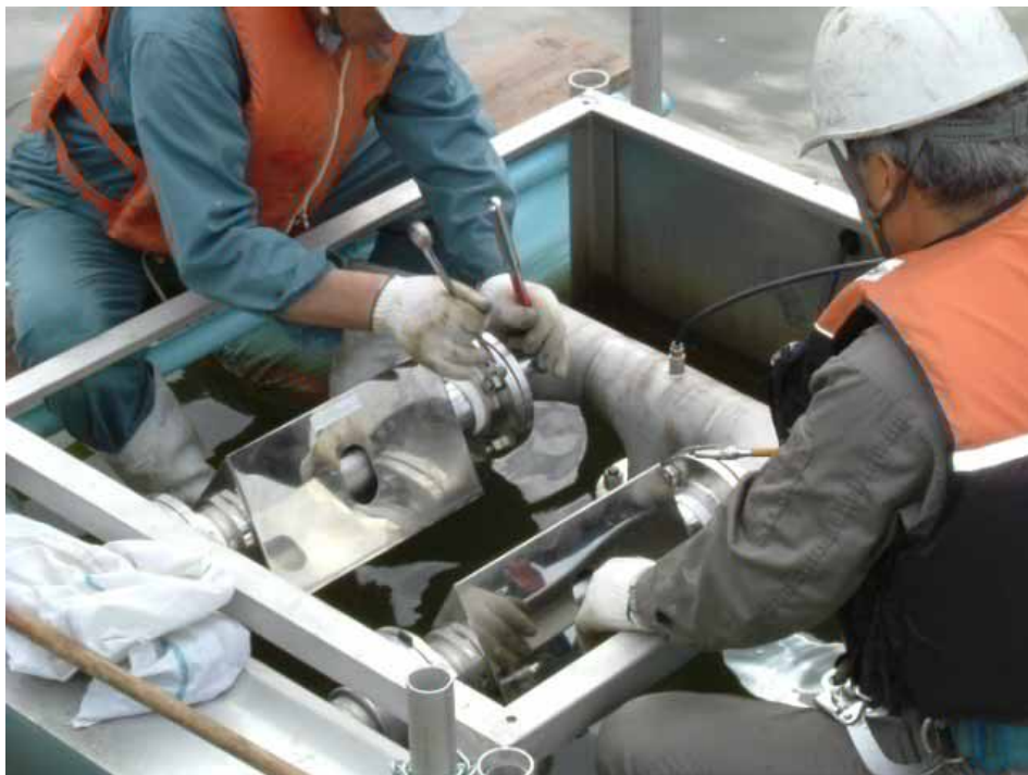
写真5 - 5 実証対象機器定期点検（平成17年11月2日撮影）
