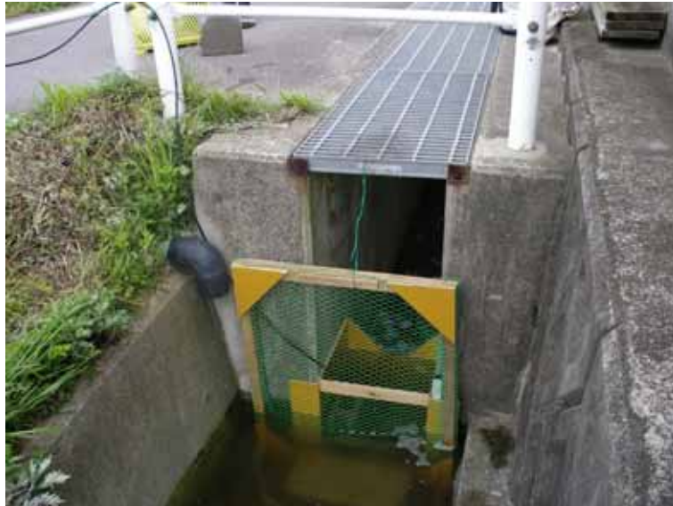
写真5-6 三角堰設置状況(実証池にて)
