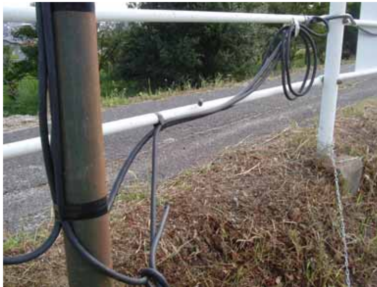
写真4 - 2 実証対象機器への電力供給配線の切断状況 (実証池堰堤、平成17年10月3日撮影)
