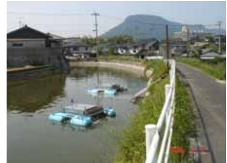
実証対象機器の設置状況 (平成17年9月2日撮影)
