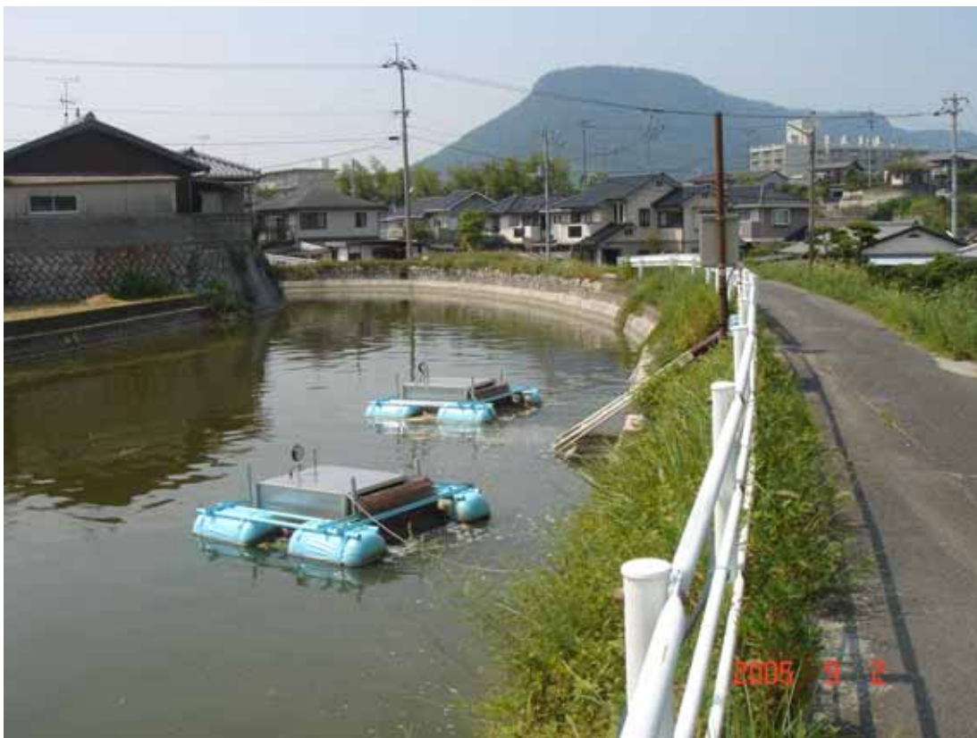
写真3 - 2 実証対象機器の設置状況（実証池（長池））
