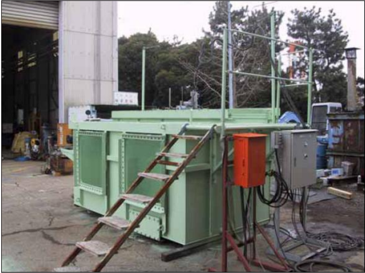
写真1 実証対象施設（T AWS 1号機）全景
