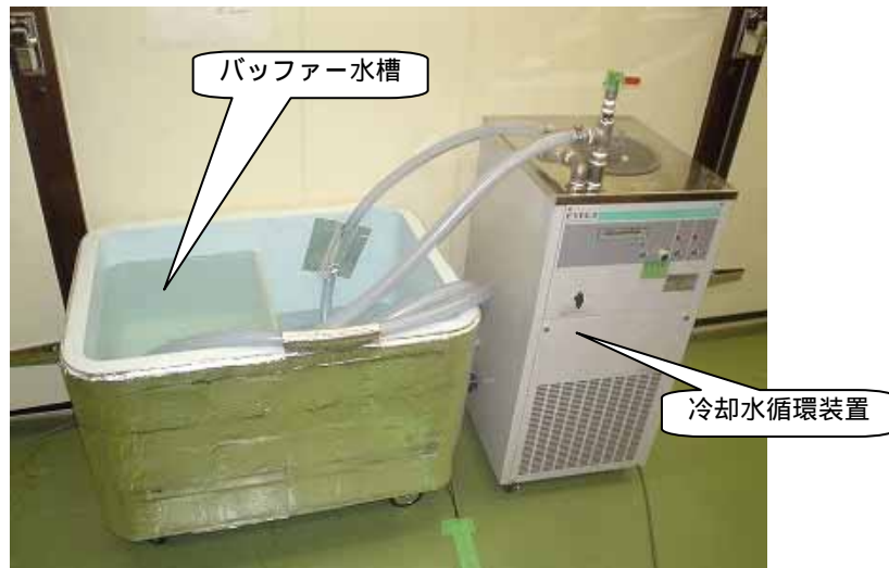
冷却水循環装置、バッファー水槽
