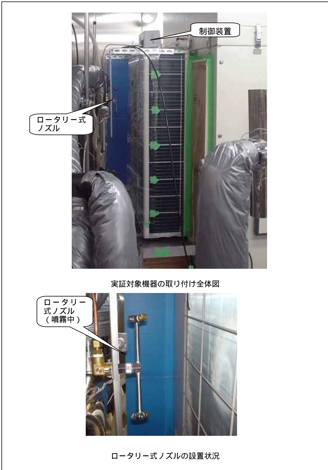
図 1 - 2 実証対象機器の設置状況
