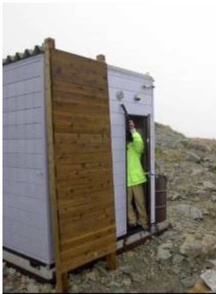
トイレ機械室部分
