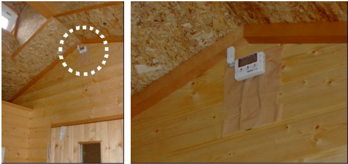
天井付近に設置した温湿度センサー
