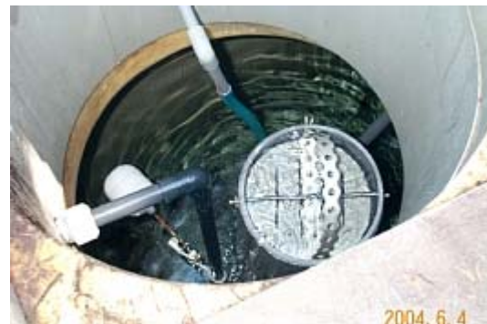
最終貯留槽（中水）
