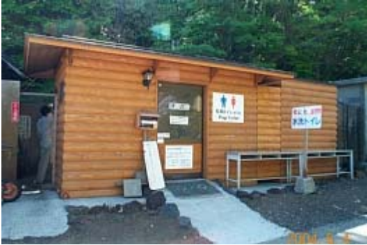
東富士山荘トイレ外観
