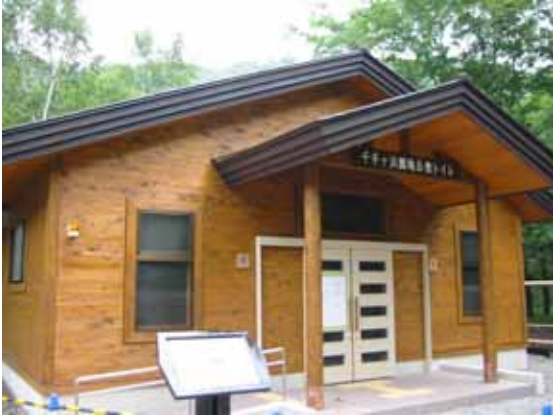
千手ヶ浜園地公衆トイレ外観
