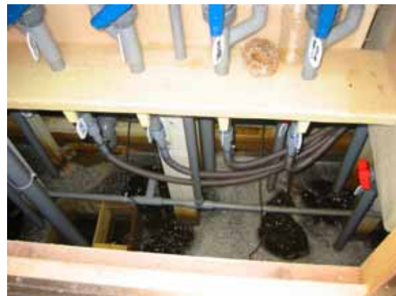
処理槽（流動攪拌室）
