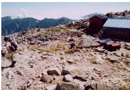
建設前の写真
