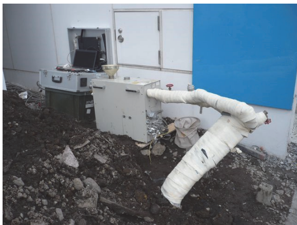
写真5 保温材を巻終った状況
