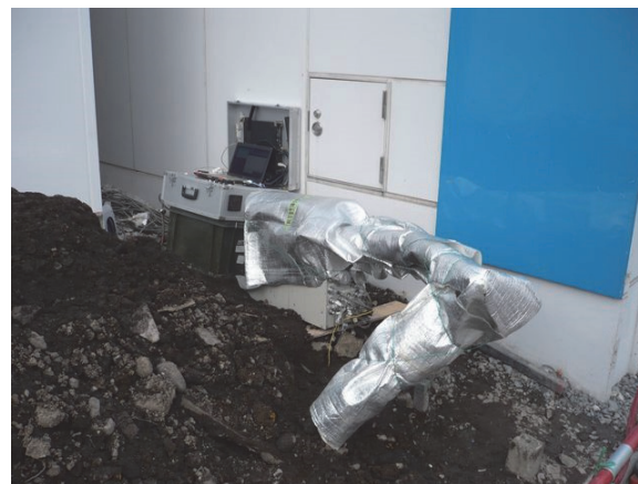
写真6 保温材の上を銀色シートを覆い、この状況で加熱循環試験を行った。
