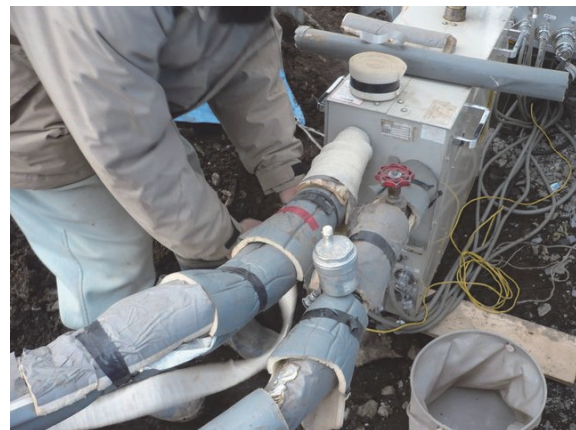
写真4 配管に保温材を巻く作業
