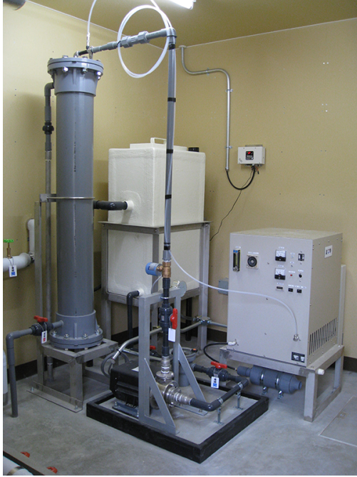
写真2 オゾン処理装置
