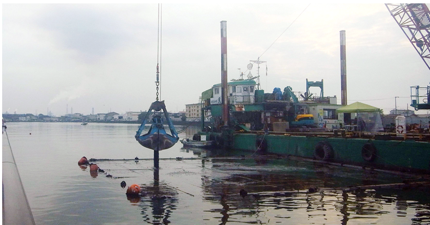
写真2 マリンストーン® 施工風景
