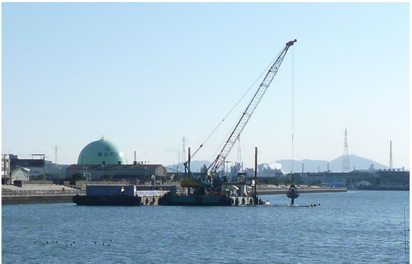
写真1 マリンストーン®（製鋼スラグ底質改善材）施工状況
