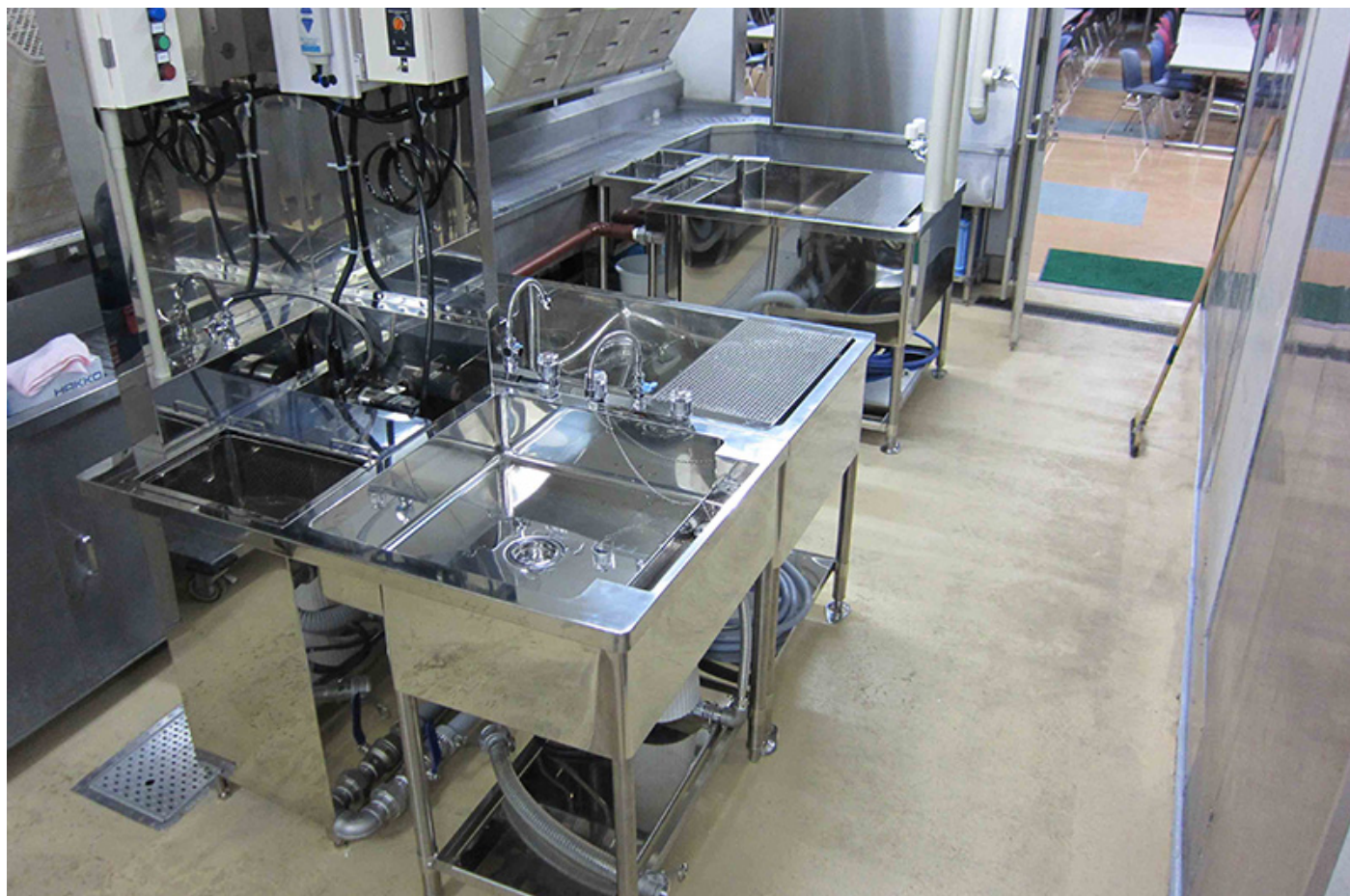
写真1 業務用厨房シンク型油水分離回収機 様々な実証技術を試した日本工業大学学食が最終的に採用したもの
