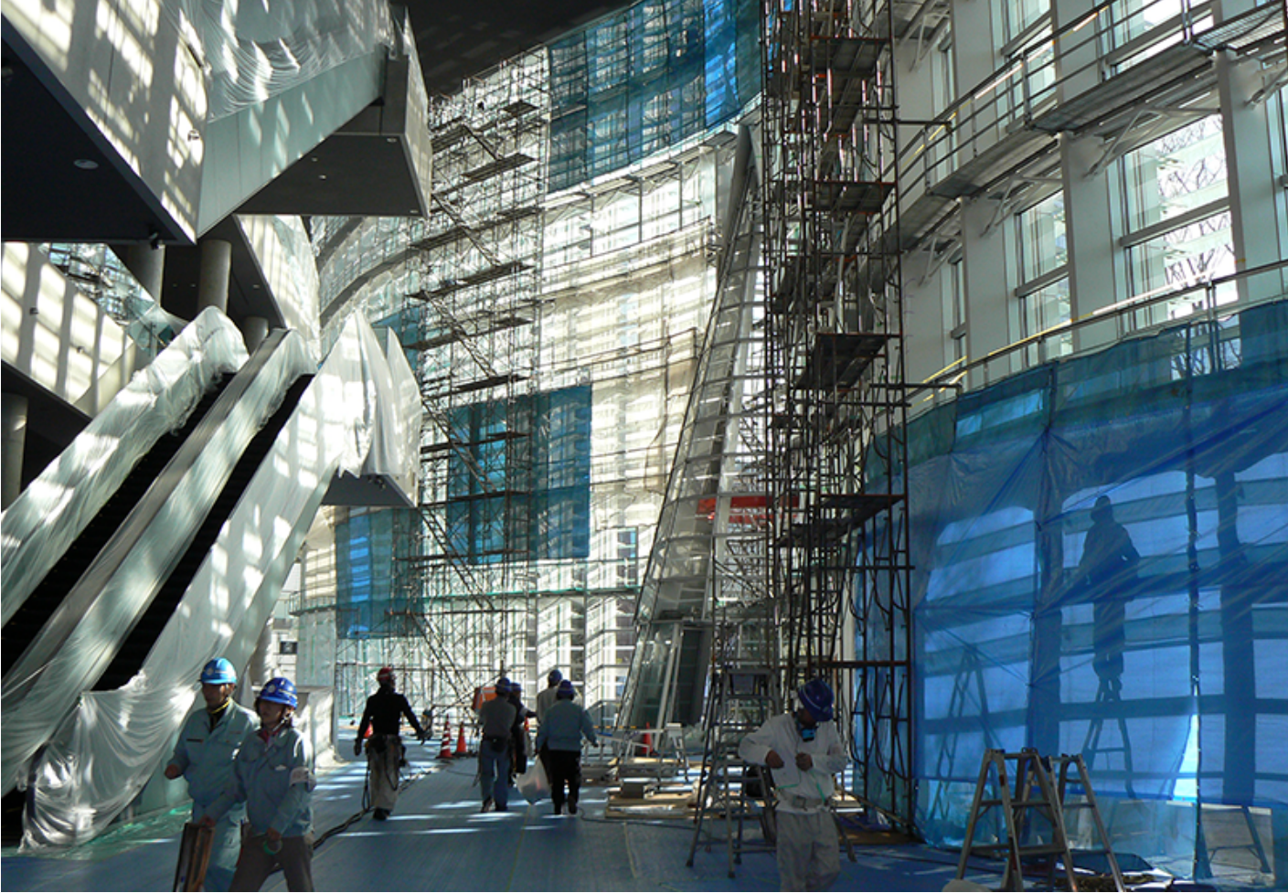
写真2 国立新美術館におけるフミンコーティング施工風景
