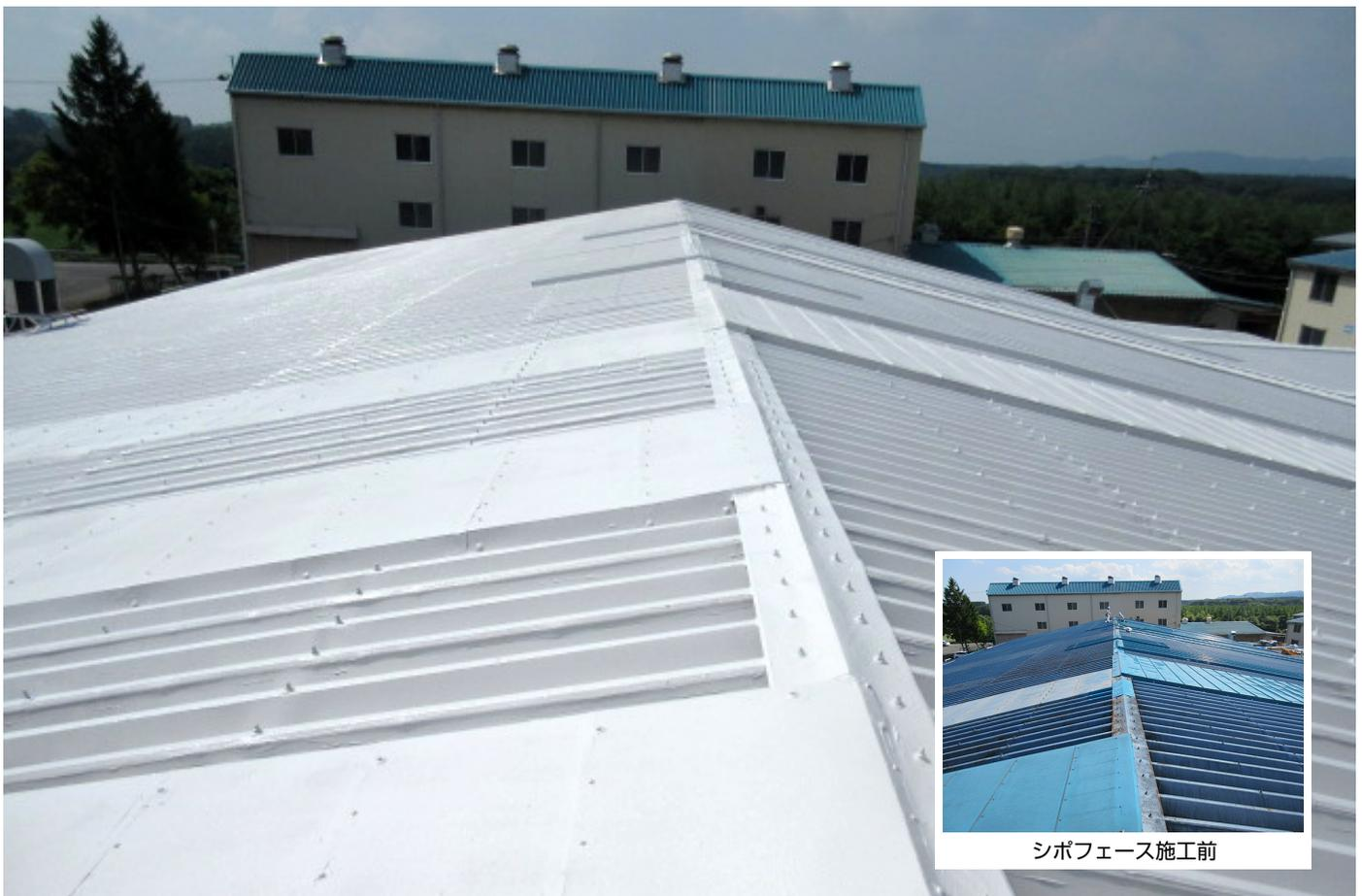
写真1 シポフェース施工後の屋根の外観
