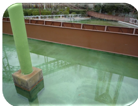
処理後の状況
