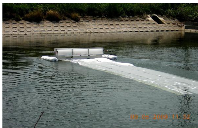
アオコ制御のための施工装置
