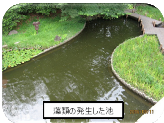
処理前の状況
