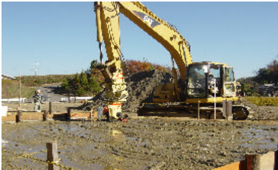
写真 1 水平ロータリー式攪拌機によるマグホワイト処理 写真 2 植栽試験 (香川県 鍛冶池底泥土)
