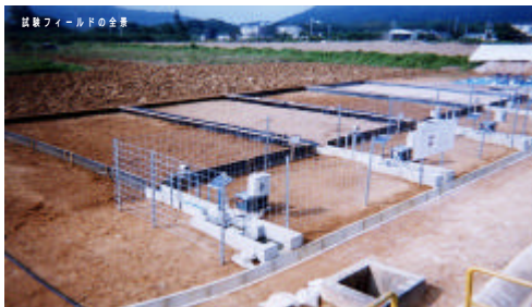
写真 3 赤土流出防止現地試験概要
