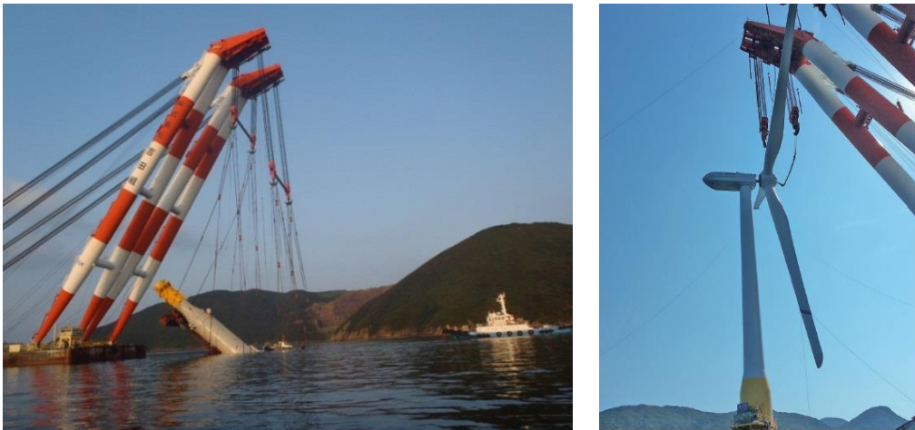
図 2. 2. 6-4 （参考）浮体部建起しと風車組立状況
