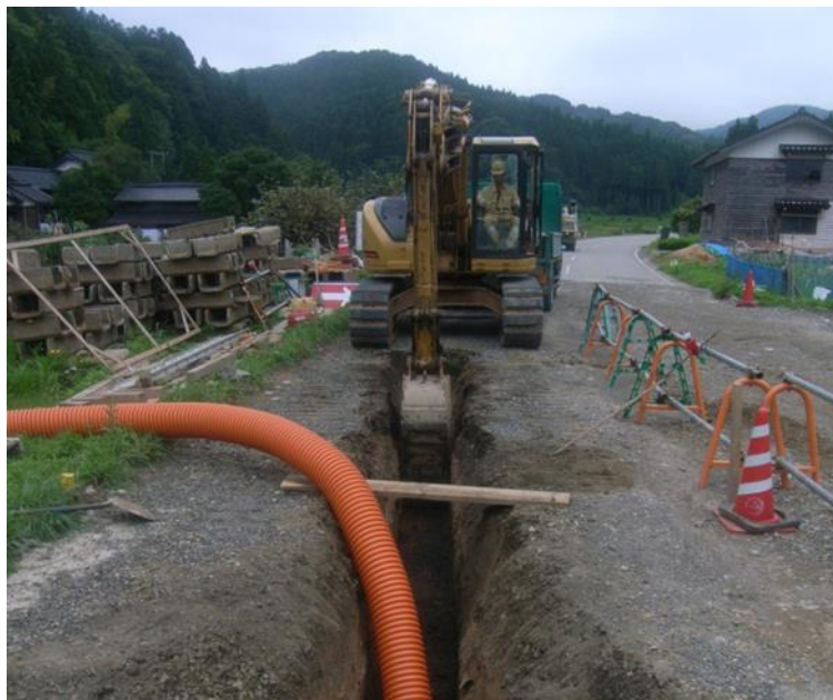
第 2.2-16 図 地中埋設線の施工(例)
