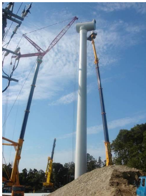
第 2.2-17 図 風力発電施設工事の状況（イメージ写真）
