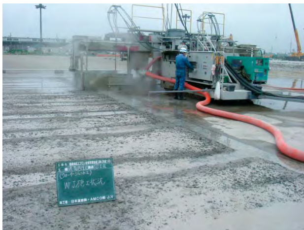
図 4.2-7 完全付着型オーバーレイ工法工事の様子
