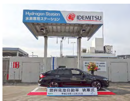
図 4.3-6 成田水素ステーション
