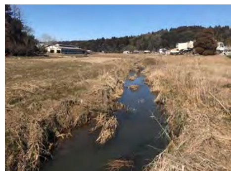
写真 11.15.3-1 傾斜型護岸箇所 (高谷川)
