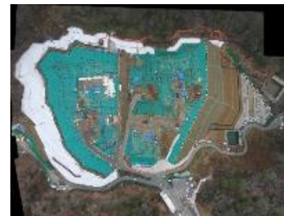
特定廃棄物埋立処分施設の様子
