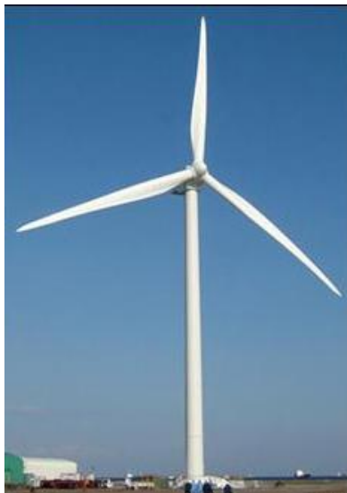
図 3-3 風力発電設備の形式（水平軸風車の例）
