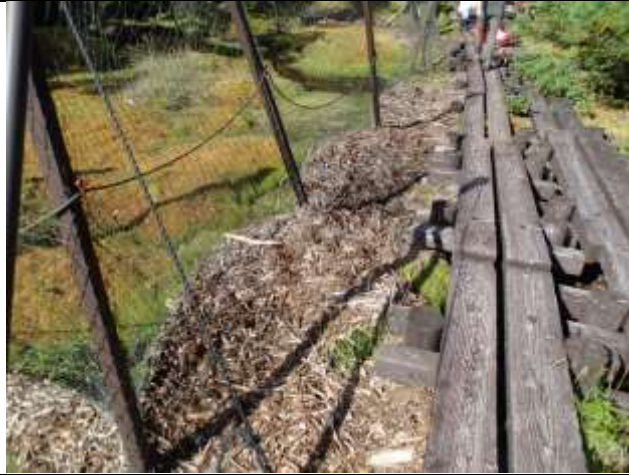
シカ柵のスカートネットに枝条が堆積
