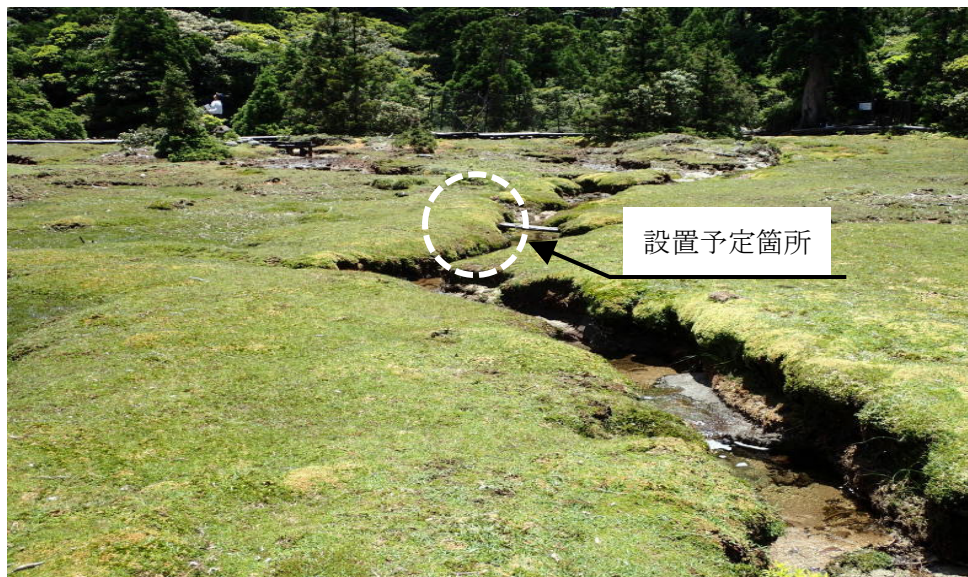
写真 4 試行的対策の設置予定箇所
