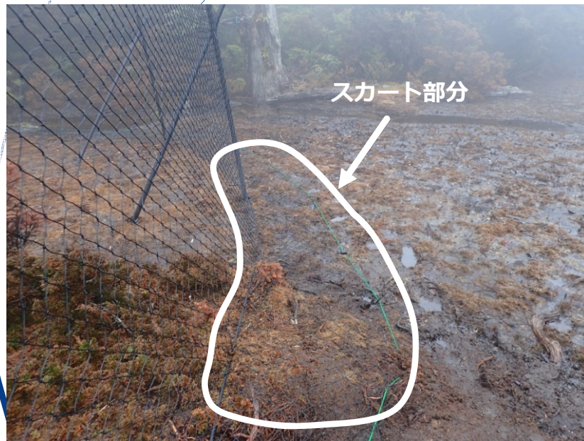
写真1 ネット張替え後 (H31年1月)
