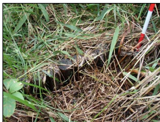
図 7.1.2 水抜き水路2 堰き止め工の末端部に設置されている土留め杭
