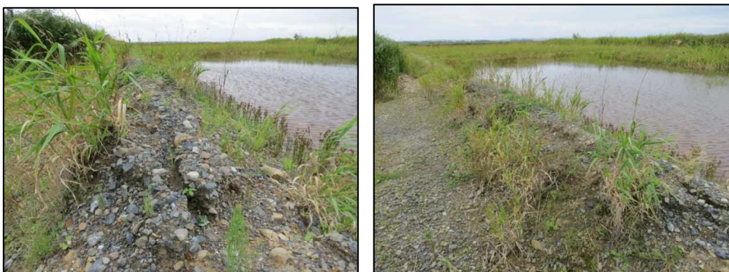
図 7.1.5 各試験区画の境界に造成された盛土の侵食状況
