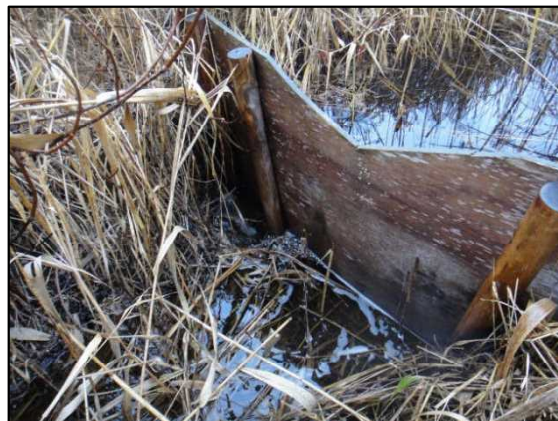
図 7.1.3 水抜き水路3に設置された仮堰
