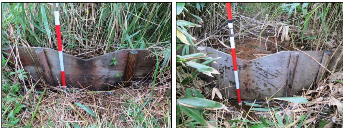
図 7.1.4 水抜き水路4（左）及び水抜き水路5（右）における仮堰の状況
