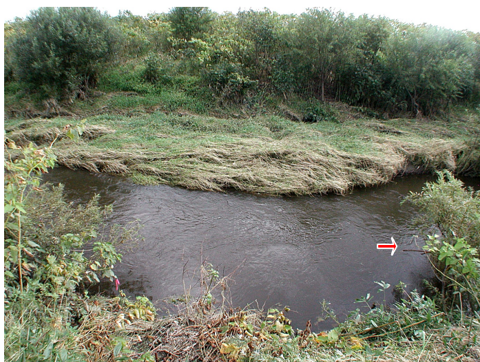
写真 8.1.4 下エベコロベツ川流路内の段丘（オンネベツ川合流後）
