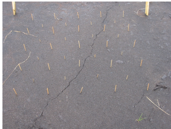
写真 6.1.31 3 真上 7月 (設置時)
