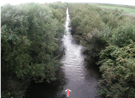
下エベコロベツ川下流部（下流側）
