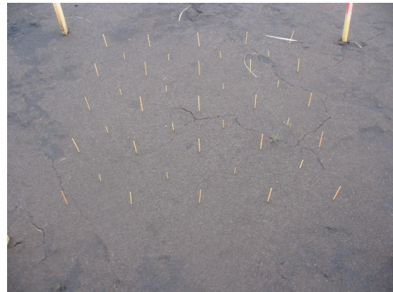
写真 6.1.43 5 真上 7月 (設置時)
