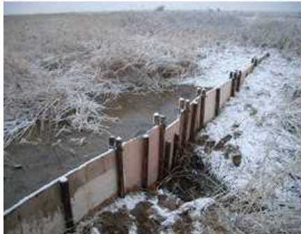
落合沼流出部 堰上げ翌朝の状況 (すでに堰天端近くまで溢水が見られる)
