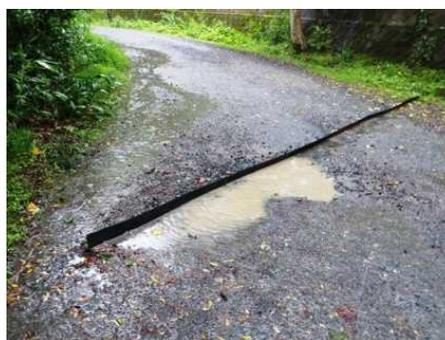
雨天時の路面状況例（洗掘による水たまり）
