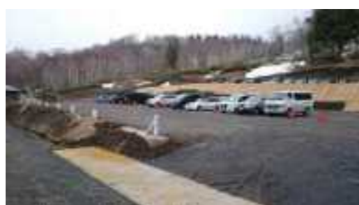
再整備箇所(完成後)
