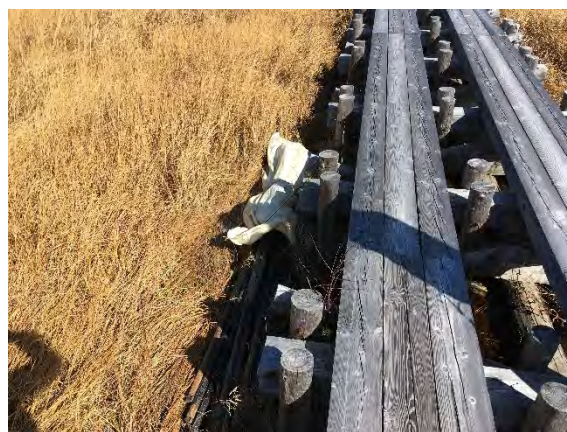
撤去状況 支柱括り付け作業
