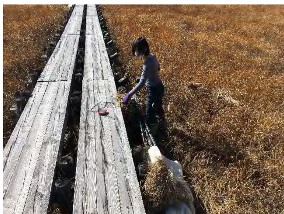
撤去状況 支柱括り付け作業
