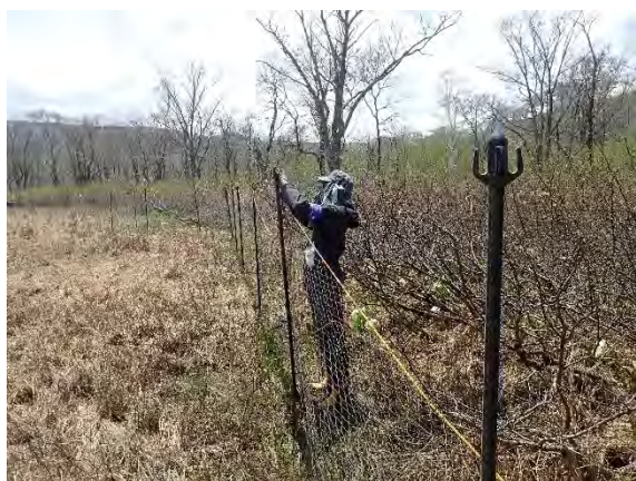
設置状況 ネット上げ
