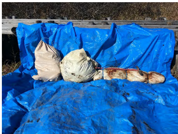
補修資材の整理
