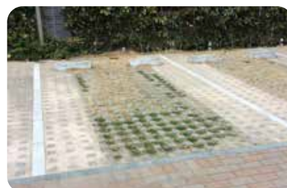
駐車場の舗装を一部緑化することで、柔らかな印象に
