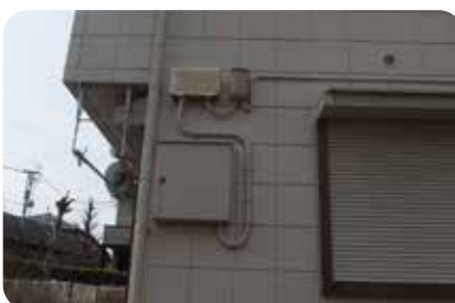
配管と外壁を同じ色合いにして目立たせない
