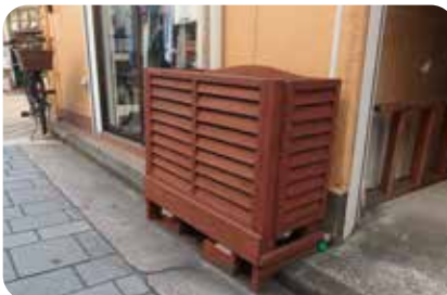
エアコンの室外機を木製のカバーで目隠し
