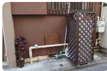
壁と同系色の化粧板で囲って、設備を目隠し
