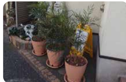
メーターを植木鉢で目隠し
