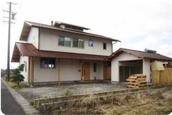
茶色系の屋根、白色の壁で付帯の建物も同様の色調で調和がとれている
