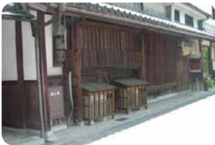
建物の雰囲気と合ったエアコンの室外機カバーで目隠し
