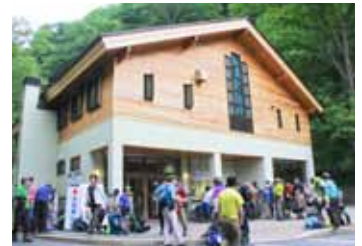
▲平成22年に完成した野島川広河原インフォメーションセンター
